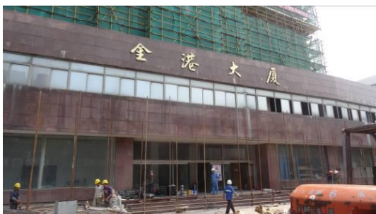
金港大厦主入口
